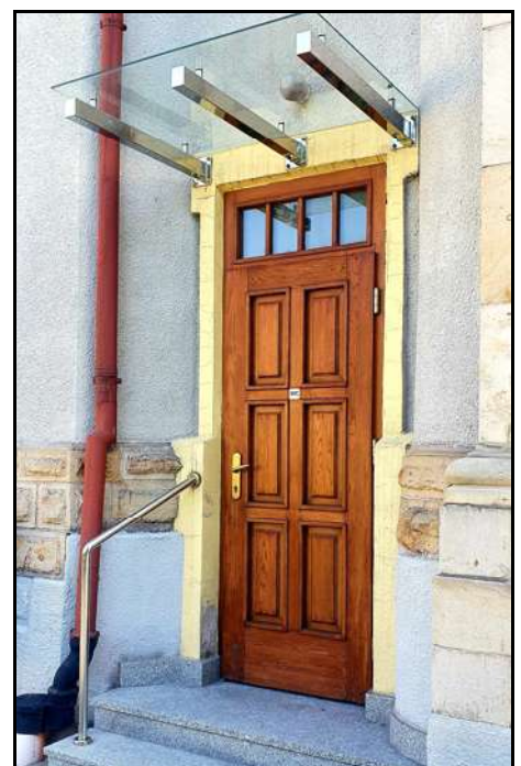
Montaż zadaszenia nad drzwiami od ubikacji
