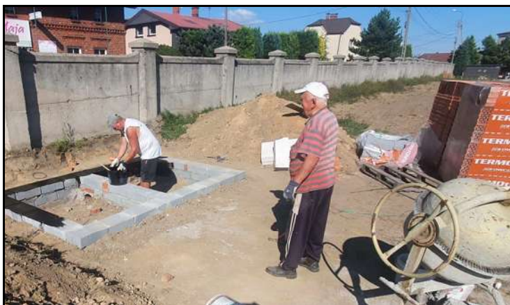
Izolacja fundamentów
