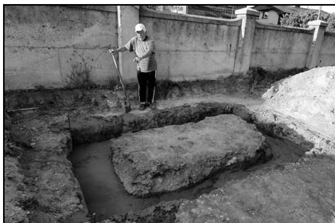
Zabetonowanie fundamentów pod toalety na cmentarzu
