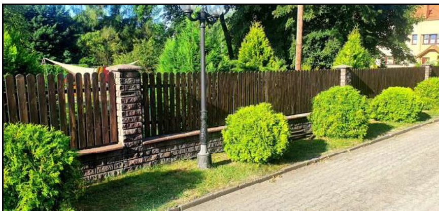
Nowe ogrodzenie od strony Przedszkola
