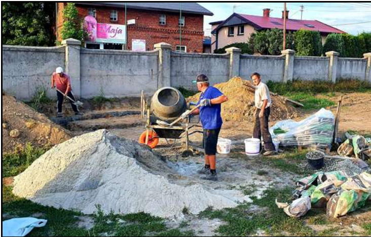
Rozpoczęcie prac związanych z budową toalet na parafialnym cmentarzu
