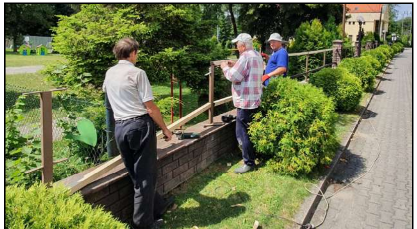
Wymiana ogrodzenia od strony Przedszkola
