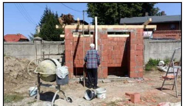
Montaż zadaszenia nad drzwiami bocznymi
