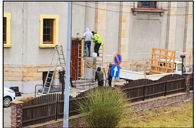
Montaż zadaszzenia nad toaletą kościelną
