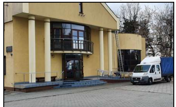
Zabezpieczenie dachu Domu Parafialnego
