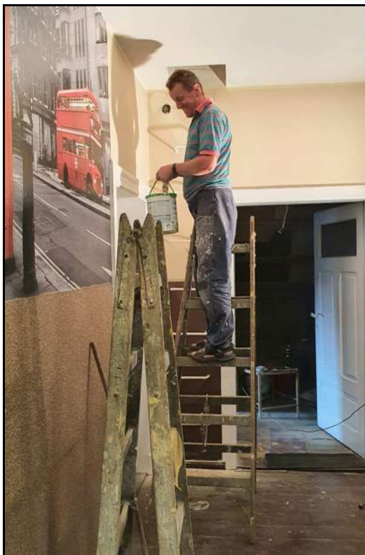
Remont kolejnych pomieszczeń na Starej Farze
