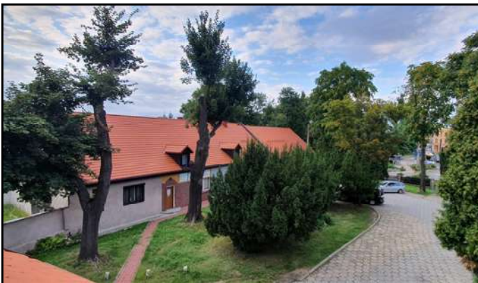
Finalny efekt remontu dachu na obiektach Starej Fary
