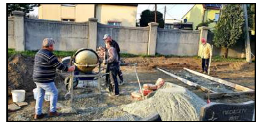
Betonowanie fundamentów
