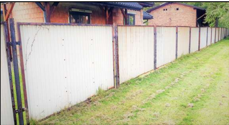
Naprawa zniszczonego „zębem czasu” metalowego ogrodzenia na terenie Ogrodu Farskiego
