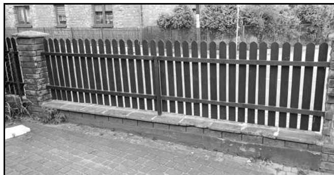
Fragment wyremontowanego ogrodzenia na Starej Farze
