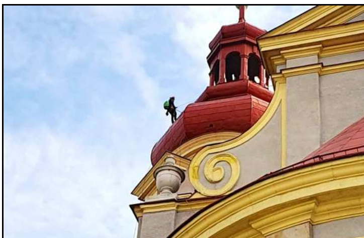
Zabezpieczenie wieży i oszacowanie stanu kopuły oraz przygotowanie do przyszłorocznego remontu tej kopuły
