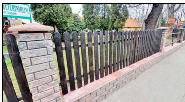
Remont pierwszej części ogrodzenia na Starej Farze
