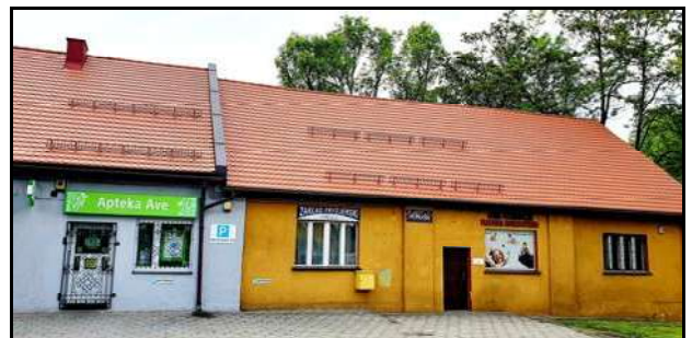
Dokończenie remontu dachu na obiektach Starej Fary
